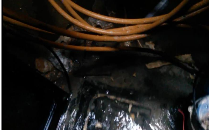
الشكل 7. غرق كوابل الاتصالات والكهرباء تحت الأرض بالمدينة.
