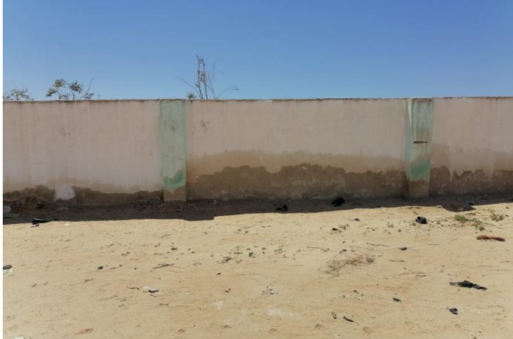
شكل 14: اضرار المياه الجوفية للأبنية من المستوى الاول.
