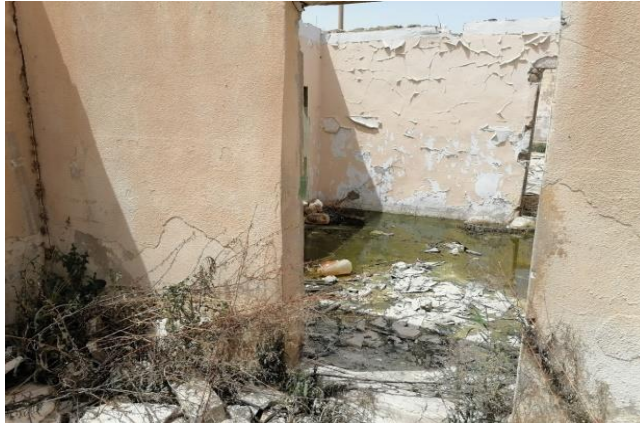
شكل 16-أ : اضرار المياه الجوفية للأبنية من المستوى الثالث.
