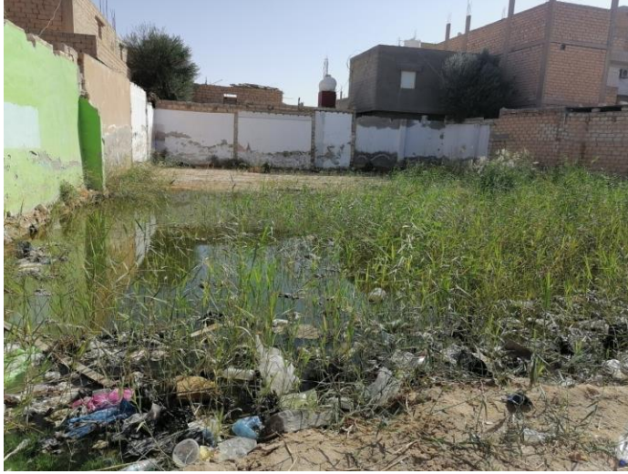
شكل 16-ب: اضرار المياه الجوفية للأبنية من المستوى الثالث.
