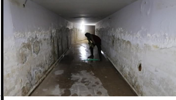
شكل 15: اضرار المياه الجوفية للأبنية من المستوى الثاني.
