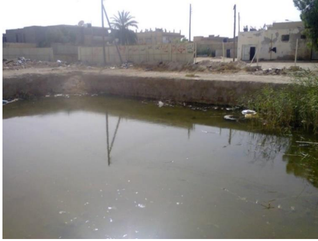
شكل 4: صورة لموقع مبنى في المدينة مهجور نتيجة ظهور المياه الجوفية.
